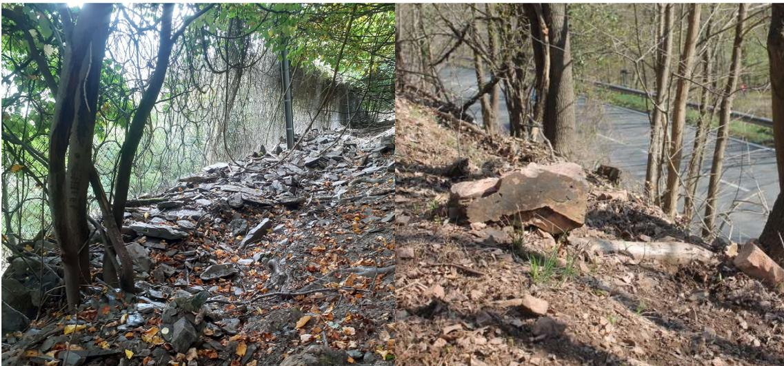
**Abbildung 2: Links: Steine und Schutt hinter Fangzaun. Rechts: Steine hinter Baum**
