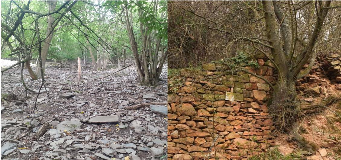
**Abbildung 3: Links: Schuttauflage durch verwitterte Trockenmauern. Rechts: Baum in Trockenmauer**
